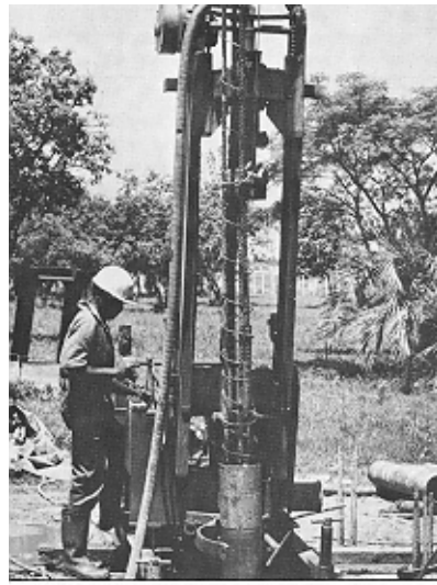
colocação da armadura
